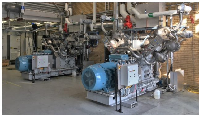
Figur 2. Två värmepumpar baserade på omvänd Stirling-teknik vid AstraZeneca i Göteborg
